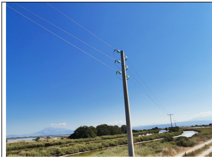
Εικόνα 2: Κολώνα με πλάγιους μονωτήρες
