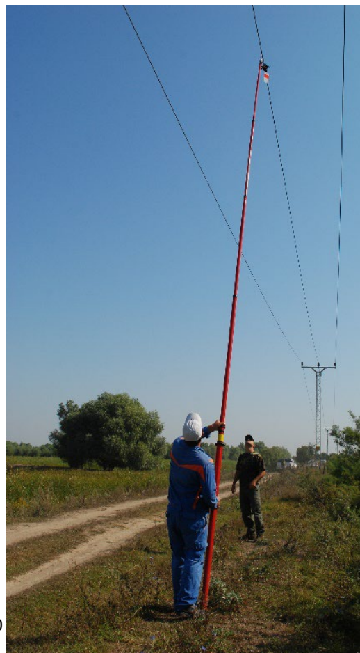
Montare dispozitive vizuale (divertoare) de tip FireFly-pentru o vizibilitate optima a liniei, dispozitivele se monteaza din app. 10 in 10 m (foto C. Mititelu)
